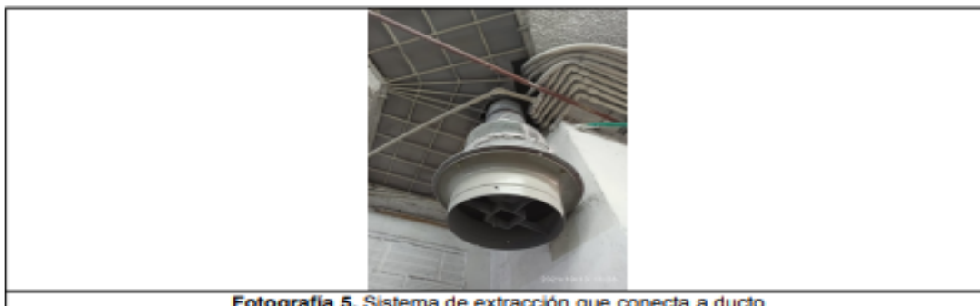
Fotografía 5. Sistema de extracción que conecta a ducto
